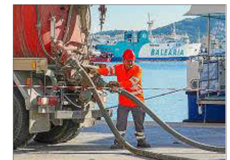
Un operario, durante la limpieza del tanque de tormentas. Foto: I.ARANGO
